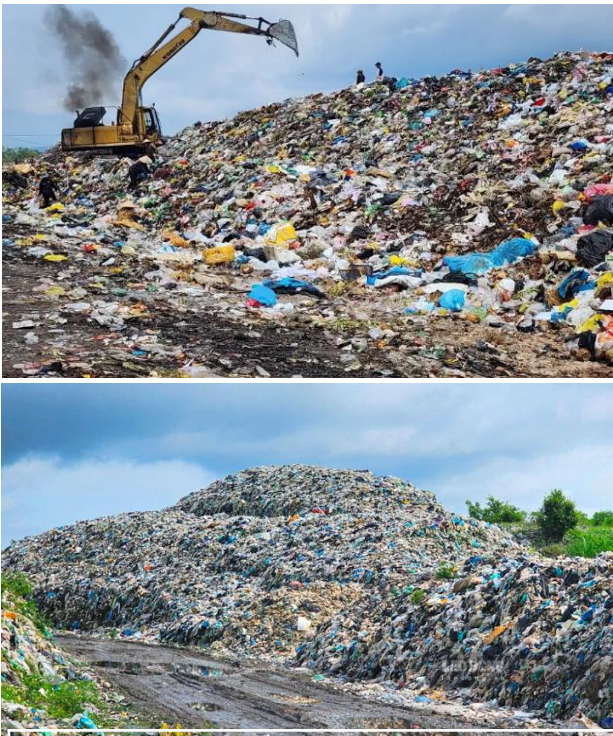
HIỆN TRẠNG BÃI TẬP TRUNG RÁC
